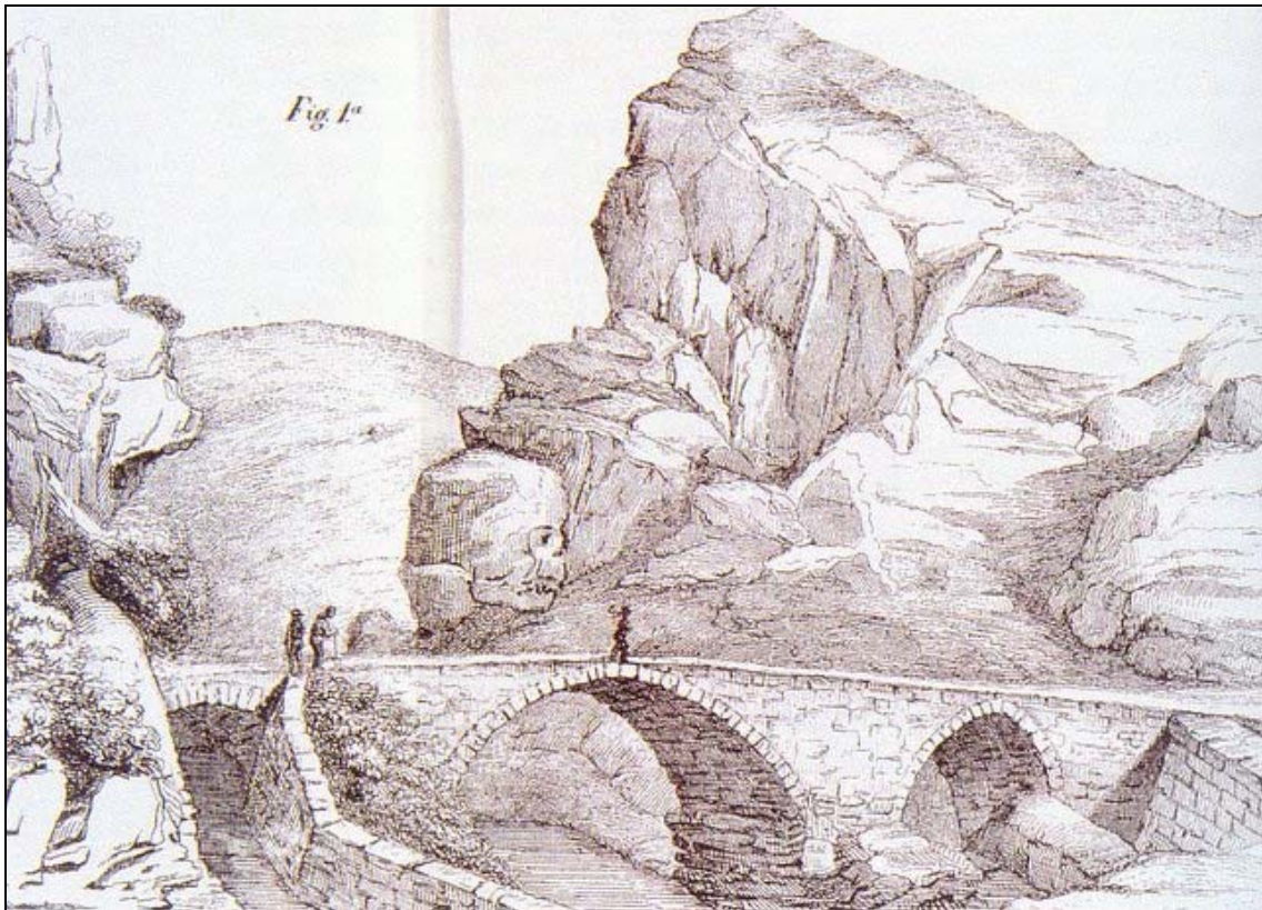
El Pontón de la Oliva, antes de la Construcción
