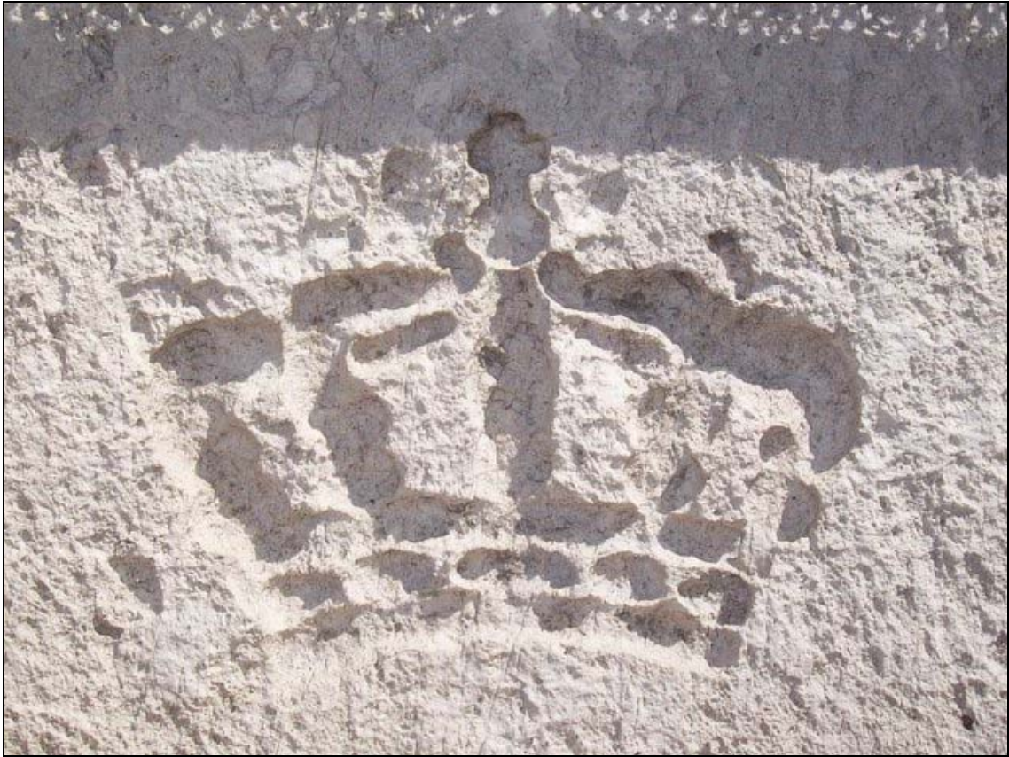
Detalle en un sillar de la presa de El Pontón de la Oliva, foto: Sergio y Poli
