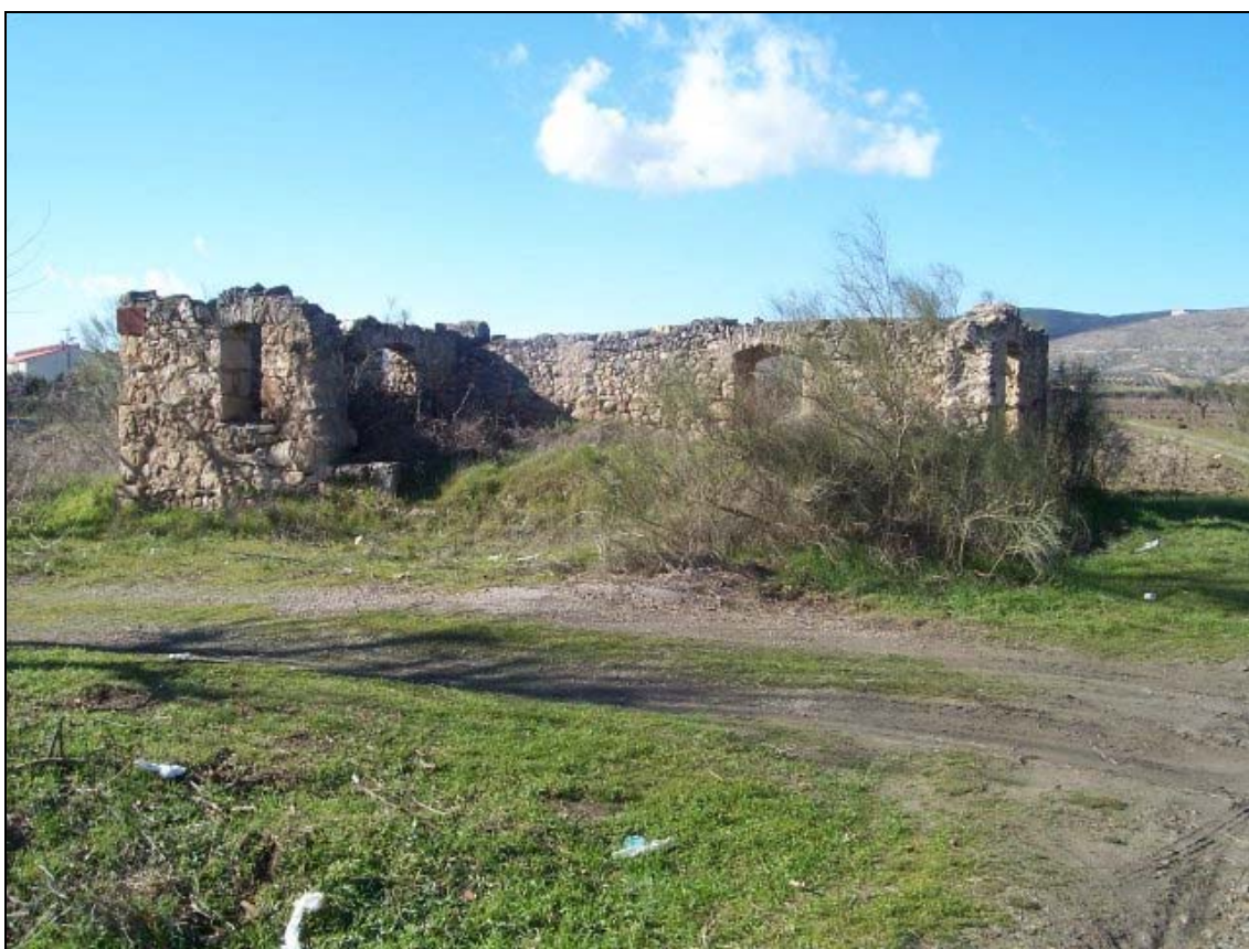
Caseta del Canal de Cabarrús, foto Óscar Jiménez Bajo
