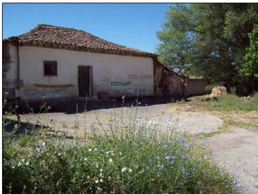
Caseta del Canal de Cabarrús “La Quintina”, foto: Sergio y Poli
